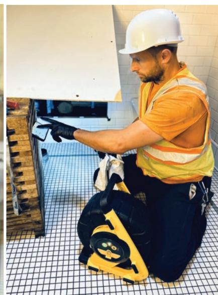
Beispiele für die Bedienung der vCamDrain über Smartphone oder Tablet mit verschiedenen Haltern. Die Kamera kann über WiFi mit mehreren Mobilgeräten verbunden werden.
