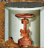
Überdeckte Schieberdeckel bis 3m Tiefe
